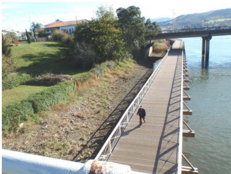
A Hendaye, une longue voie cyclable et piétonne rejoint l'Espagne en passant sous de nombreux ouvrages d'art.
