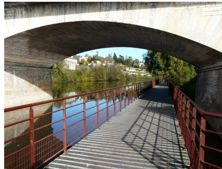
A Périgueux, la voie verte sous le Pont Barris permet un passage confortable.
