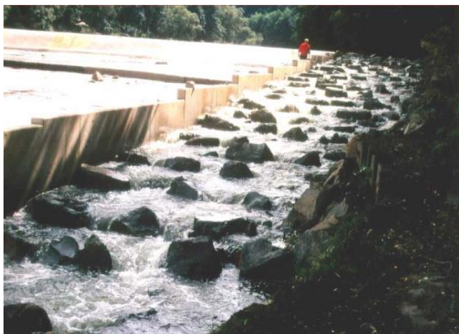
Rampe d'enrochements en rangées périodiques (source : Agence de l'eau Adour Garonne, 2006).
