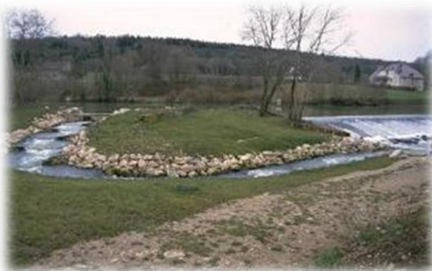
Schémas d'une rivière de contournement et de rampes installées sur tout ou partie de la largeur d'un obstacle.
