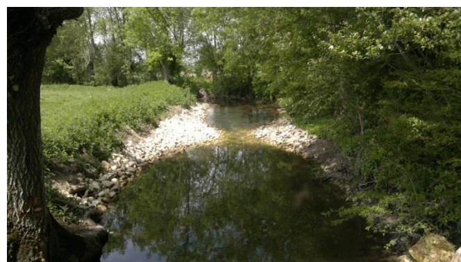
(Source illustration : S3R, pincement des écoulements sur le bief Chabot (Guirande), Avant/ Pendant/ Après travaux)
