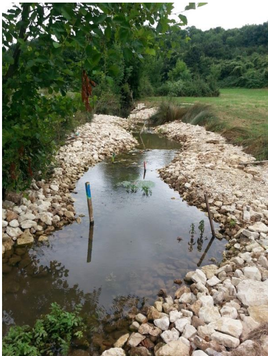
Illustration : Recharge granulométrique sur le Lambon et un de ses affluents en 2016
