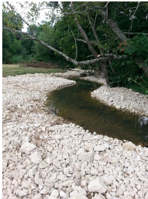
Illustration : Recharge granulométrique sur le Lambon et un de ses affluents en 2016
