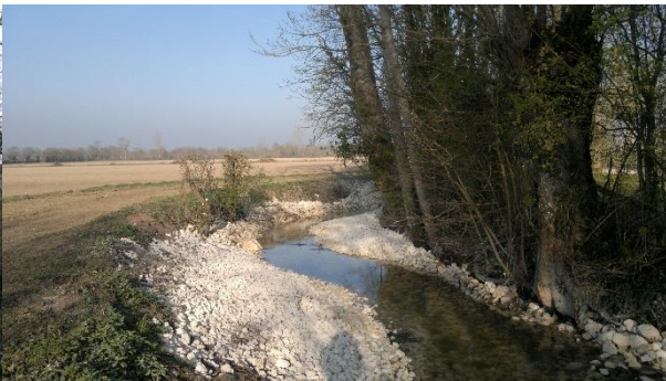
Illustration : Recharge granulométrique sur le bief Chabot avant / après travaux Eté 2010 fin des travaux – mai 2012
