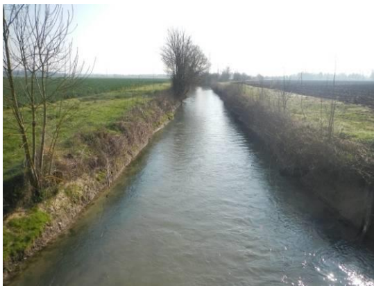
Figure 33 : Travaux hydrauliques sur la Guirande (Les Essards)
