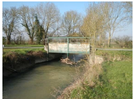
Figure 34 : Barrage à Vantelles
